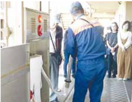
▲設置された消火栓の使用法を消防士から学ぶ参加者
